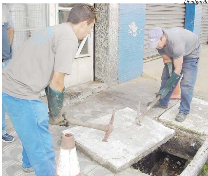
Profissionais limpam galerias de águas pluviais e bocas de lobo
