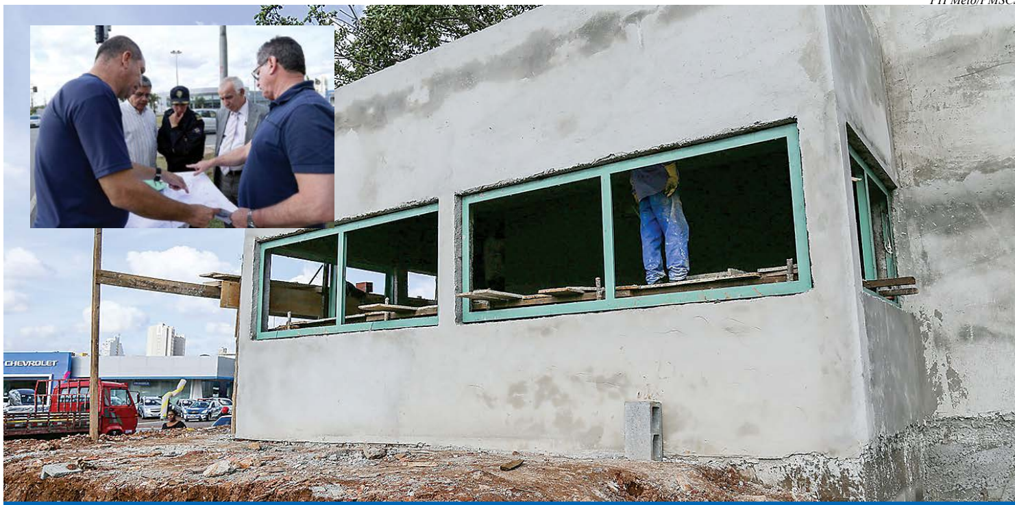
Equipe da Secretaria de Segurança de São Caetano visitou as obras da nova base da cidade
