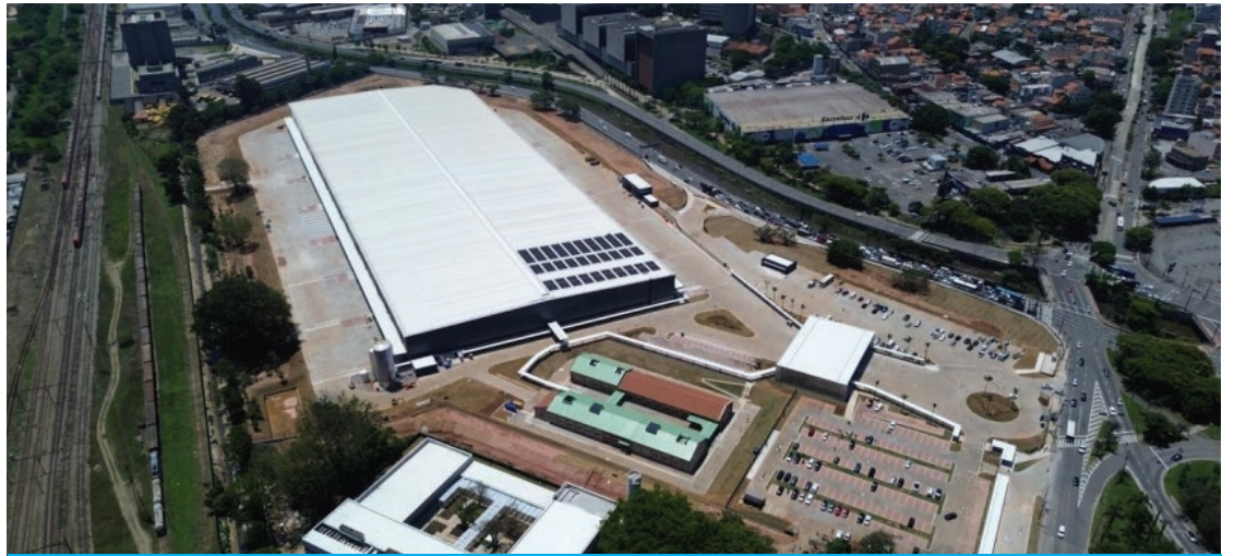
Construído em área de 60 mil m 2 , empreendimento foi projetado para atender empresas de e-commerce, bens de consumo, logística, setor farmacêutico e produtos de alto valor agregado
