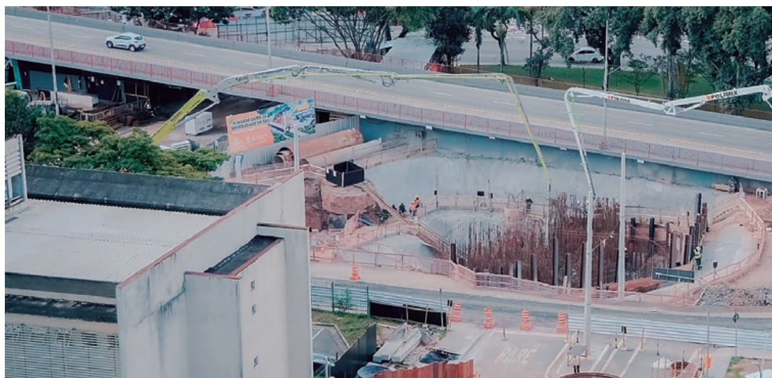
Expectativa é a de que a obra reduza em até 40% o volume de veículos no entorno do Paço Municipal
