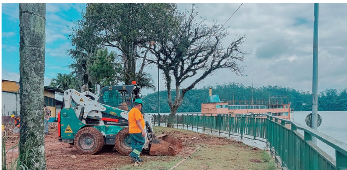
Requalificação de 20 mil metros quadrados e faixa de 800 metros às margens da Billings
